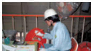
住宅部材として使用するケーブルをカットする作業
