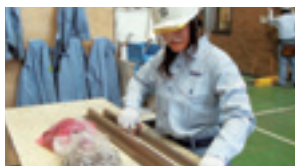
水切りの裏側に両面テープを貼る作業
