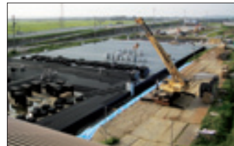
クロスウェーブの施工風景
