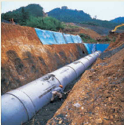
エスロンパイプの埋設
