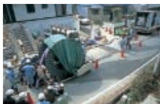
住宅密集地での施工状況
