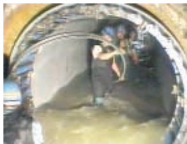
下水を流したままでの施工状況
