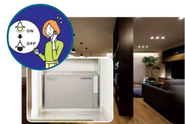
■大容量蓄電池(12kWh)による停電の暮らし体験(イメージ)
