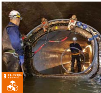
管路更生工法 (SPR工法)
