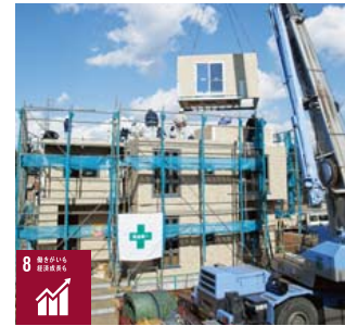
住宅ユニットの据え付け風景
