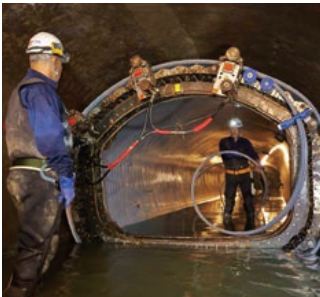
下水道管路更生
