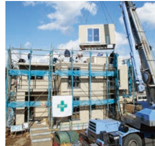
住宅ユニットの据え付け風景
