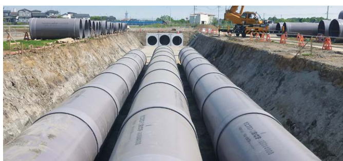
自然災害に対応するレジリエンスな地下インフラ
