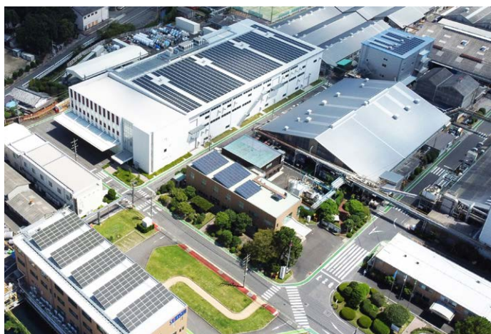
積水化学工業株式会社 滋賀栗東工場
