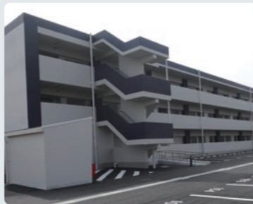
災害公営住宅の給排水パイプには、積水化学の製品が使われている
