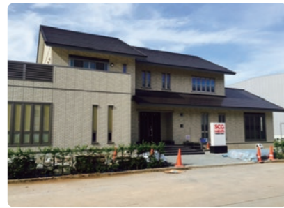
施工研修センター
