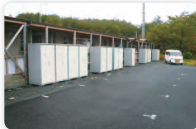
応急仮設住宅の物置設置工事
