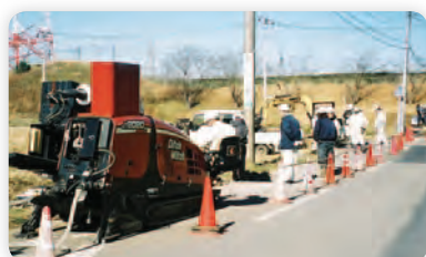
アーバンノーディグ工法による施工の様子
