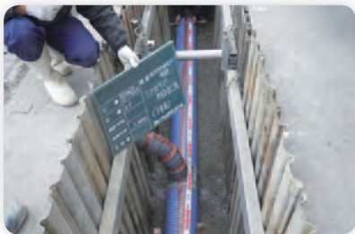
下水道工事状況
