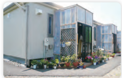
応急仮設住宅の風除室設置工事
