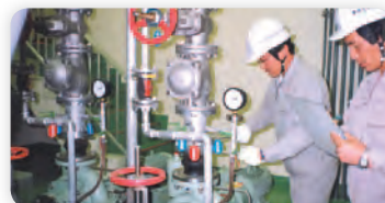
処理施設での機器点検の様子
