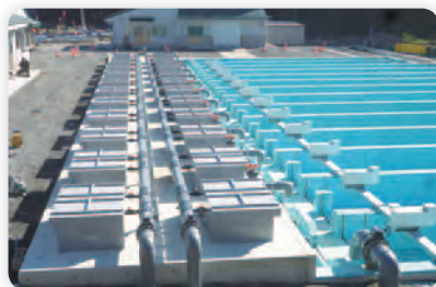
岩手県内のサケマスふ化場の再建工事
