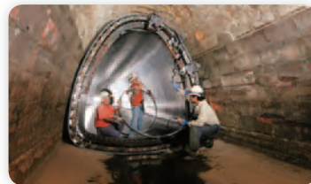
管路更生工法「SPR工法」
