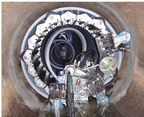
管路更生「SPR工法」
