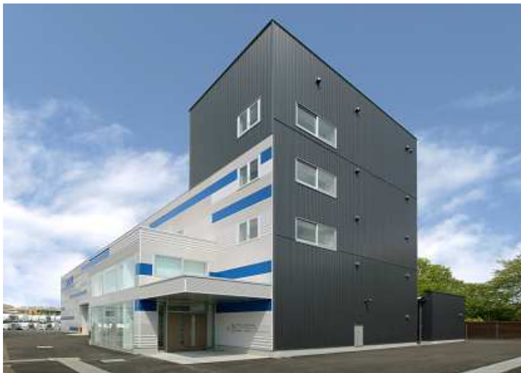
千葉ソリューションセンター 外観
