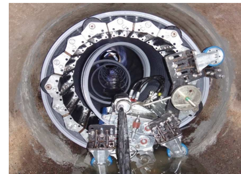
管路更生「SPR工法」
