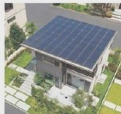
大容量太陽光発電システム
