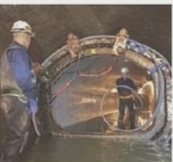
下水道管路更生
