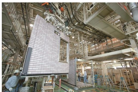
外壁取り付け
