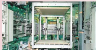
住宅生産工場(ユニット)
