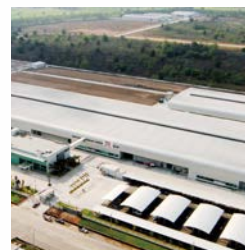
タイ住宅生産工場
