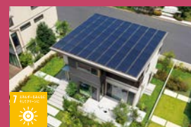
大容量太陽光発電システム
